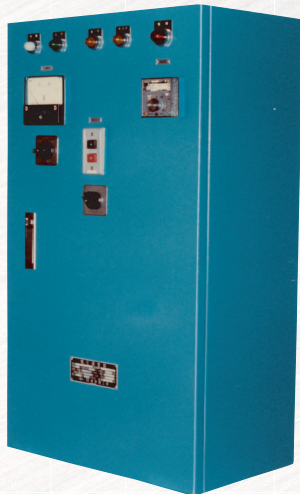
燃料発電機試験装置 Fuel Cell Testing Equipment
